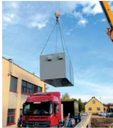
Großer Aufwand beim Aufstellen des Sicherheitscontainers.
