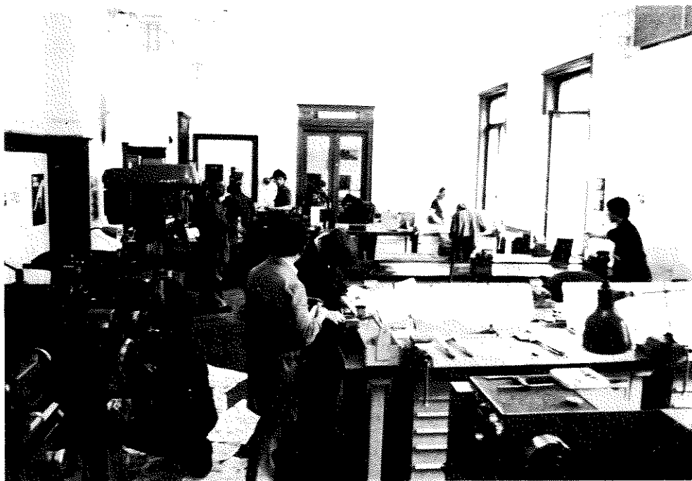
Die Schlosserei in der umgebauten Schalterhalle des alten Postamtes
