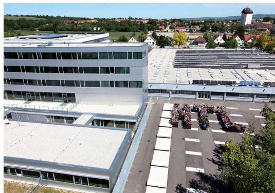
(b) Neubau, neuer und alter Werkstättentrakt
